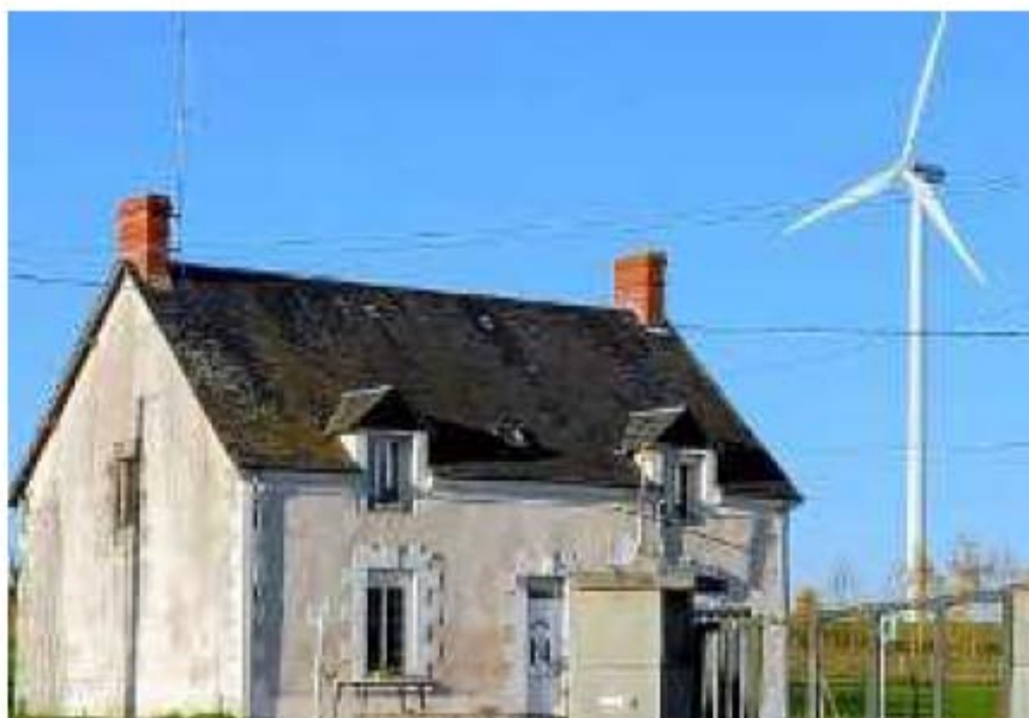
Antennes télé et éoliennes ne font pas bon ménage.
